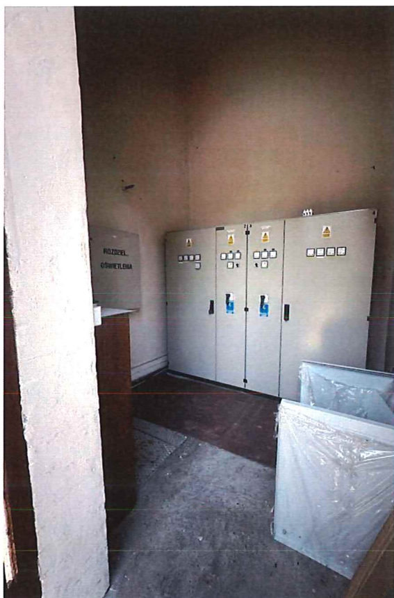
Figura 4 Pomieszczenie techniczne z miejscem wpięcia PV
